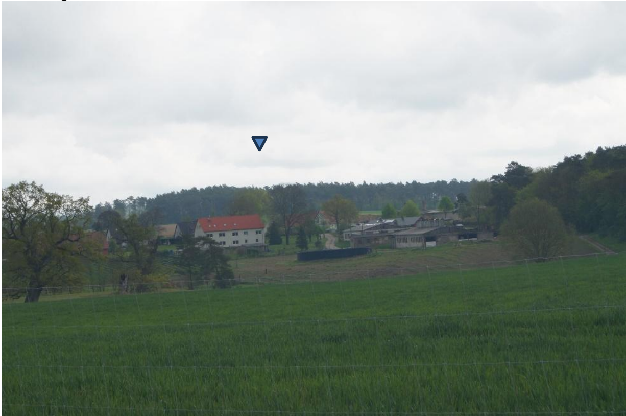
Abbildung 16: Fotostandort auf Baudenkmal mit Blick zum Vorhaben
